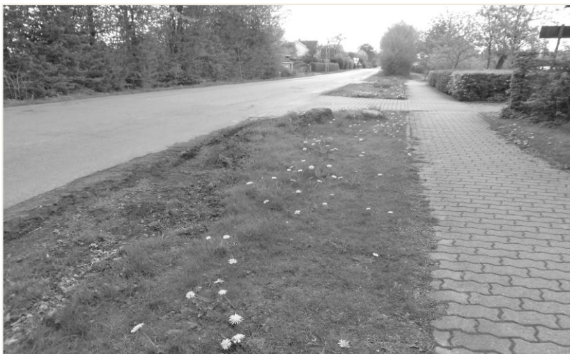
... es geht weiter ... Bauarbeiten an der L200 / L220
